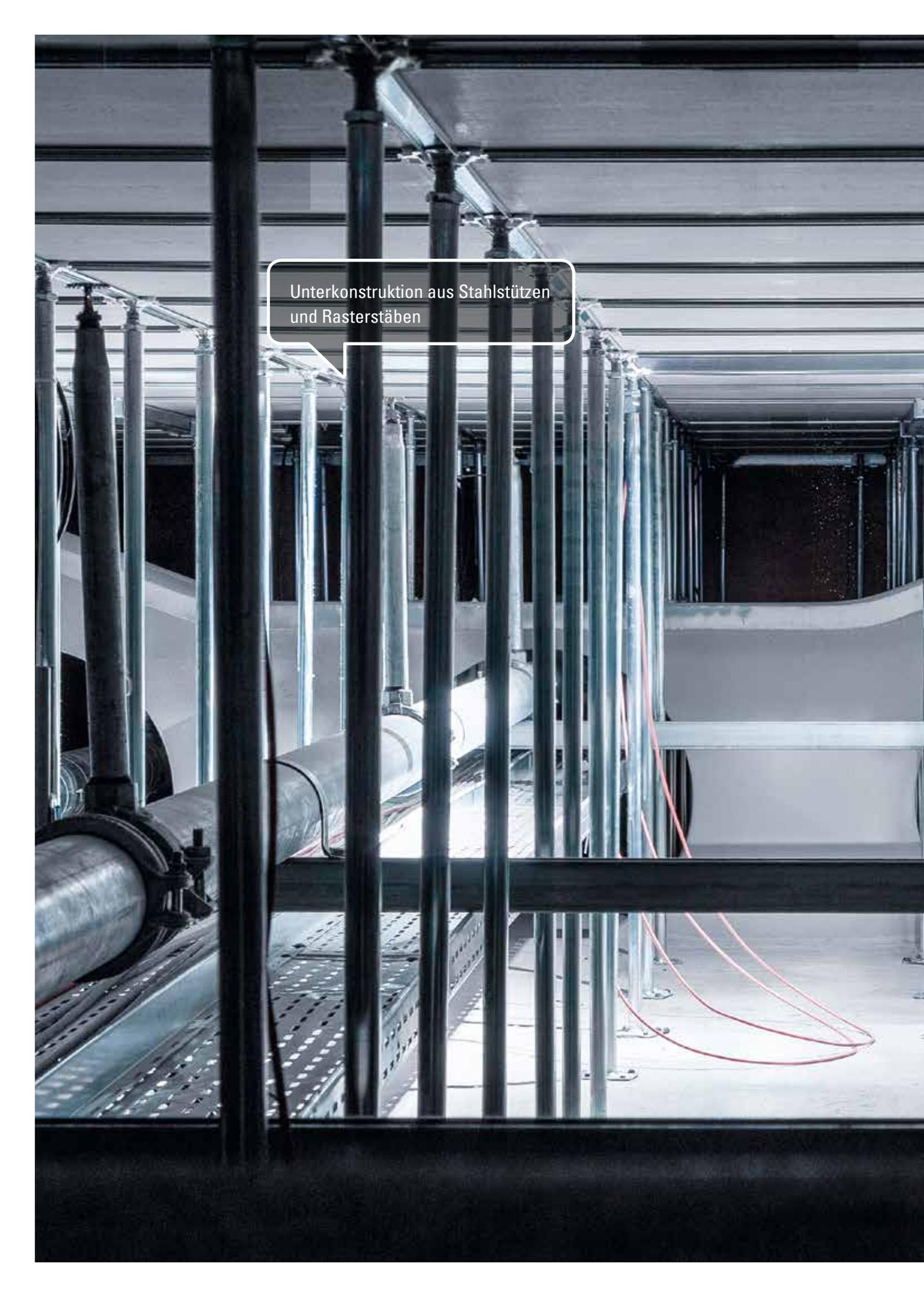
Unterkonstruktion aus Stahlstützen
