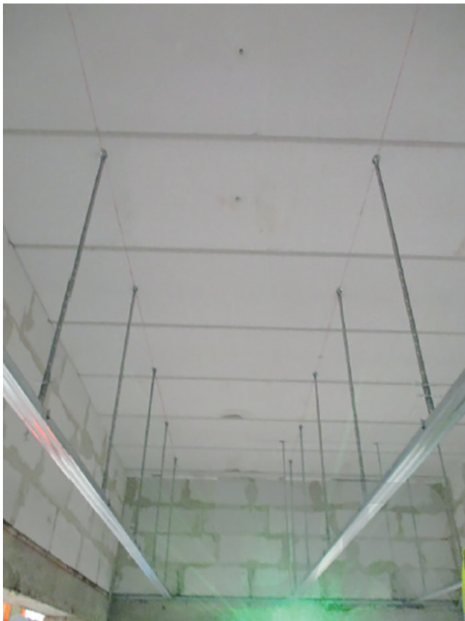
Aufbau der Decke im Prüfraum
